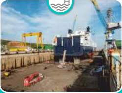
Kuru Havuz (Gemi Tamir, Bakım ve Onarım)
